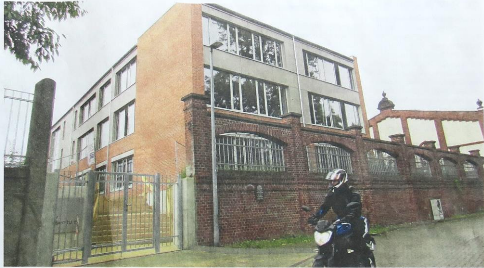
Noch nicht nutzbar ist der neue Zugang zum Oberstufenbau der IGS Wallstraße von der Straße Am Teichgarten aus. Das Schulgebäude, das in Rekordzeit von 14 Monaten erstellt wurde, wurde gestern von den Schülern und Lehrern bezogen.
